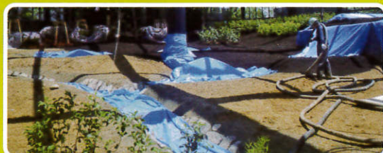
植生基盤吹き付け
