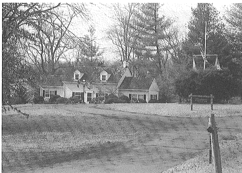
図2. エアリセンターの小さな建物の一つ。
