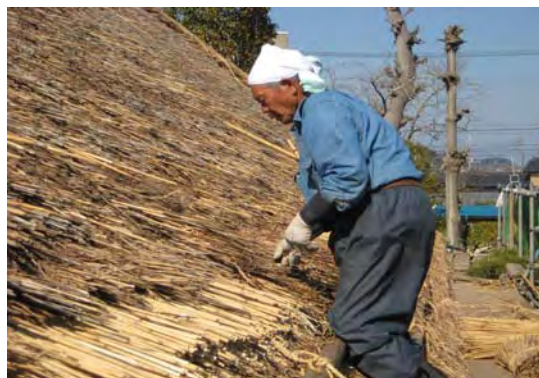
山武市・伊藤左千夫の生家 屋根改修作業中の佐藤講師 2008.5.14 茅葺屋根の準備葺の加工作業
