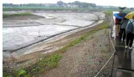
01.5 整備検討会が工事現場を視察
