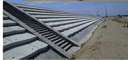
建設が進む防潮堤 2013. 5. 10
